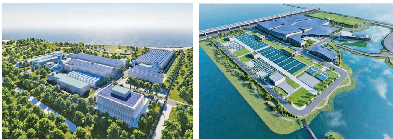
圖 7 新竹海水淡化廠（左）及臺南海水淡化廠（右）
