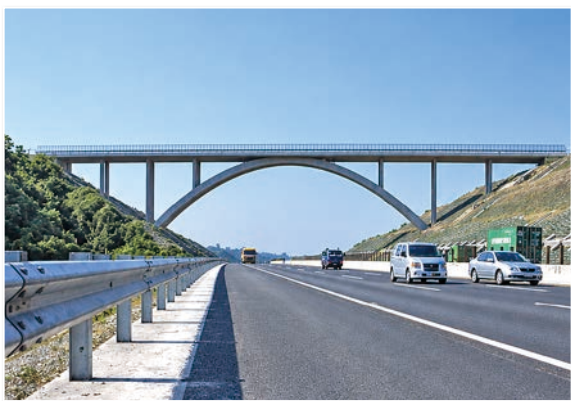
圖 14 中二高通宵一號跨越橋
