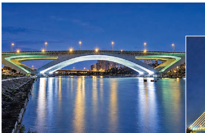
圖 12 北二高碧潭橋夜景
