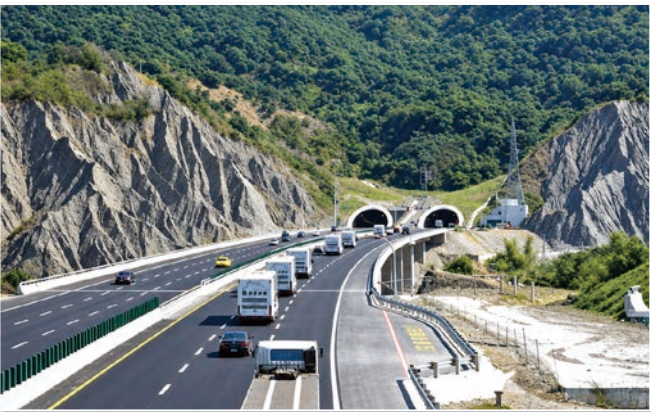
圖 10 田寮高架橋與中寮隧道景觀
