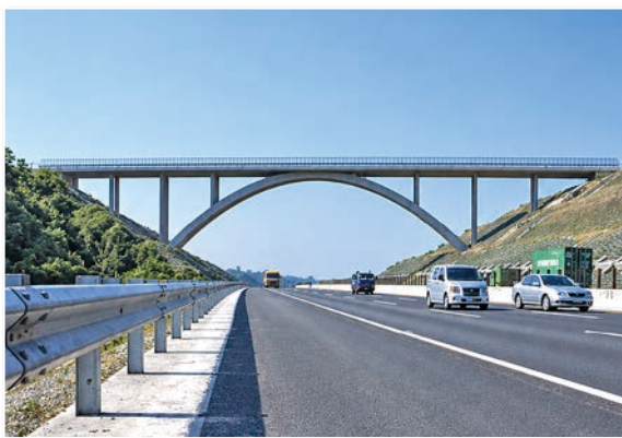
圖 14 中二高通宵一號跨越橋
