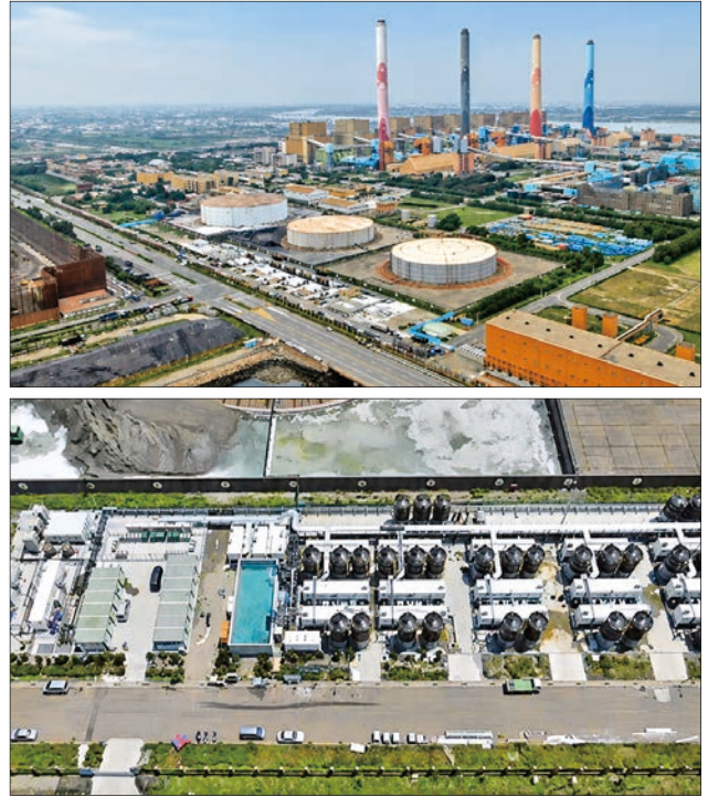
圖 5 臺中緊急海淡設施
