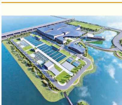
臺南海水淡化廠
