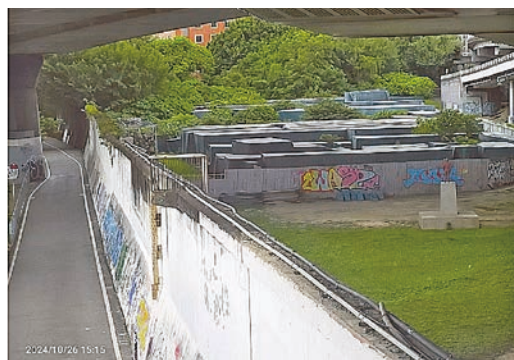
照片 8 橋材堆置場（左側為防洪牆道路）
