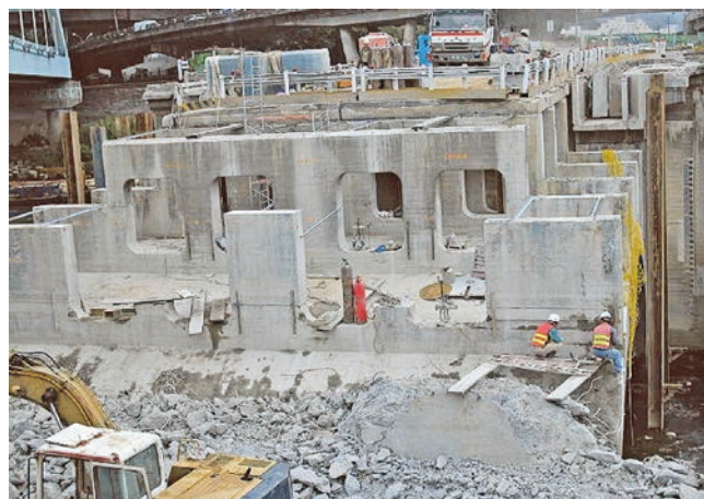
照片 9 舊橋切割拆卸施工（作者不詳）
