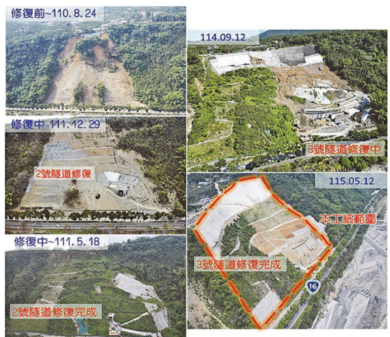
圖 22 本工程範圍邊坡整治施工前後對照
