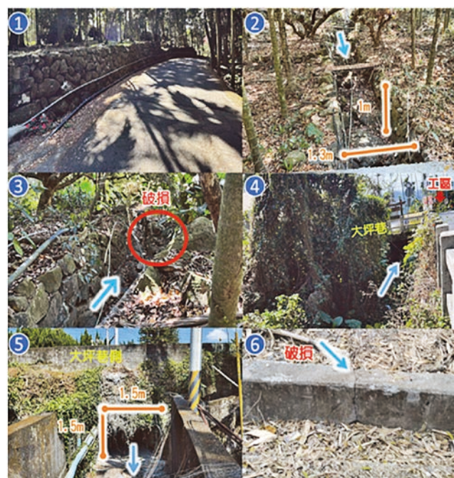
圖 10 工址上方集水區範圍調查現況照片
