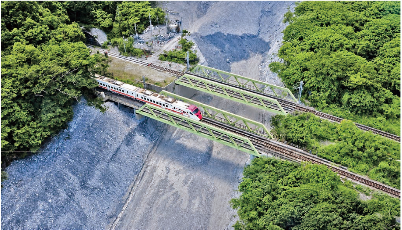
圖 9 小清水溪橋工程雙線通車空拍照片
