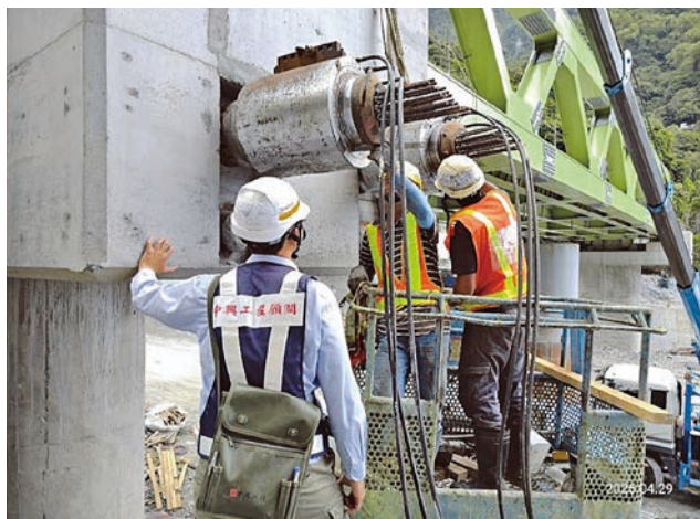
圖 8 東小清水溪橋橋面板澆置後施拉預力照片
