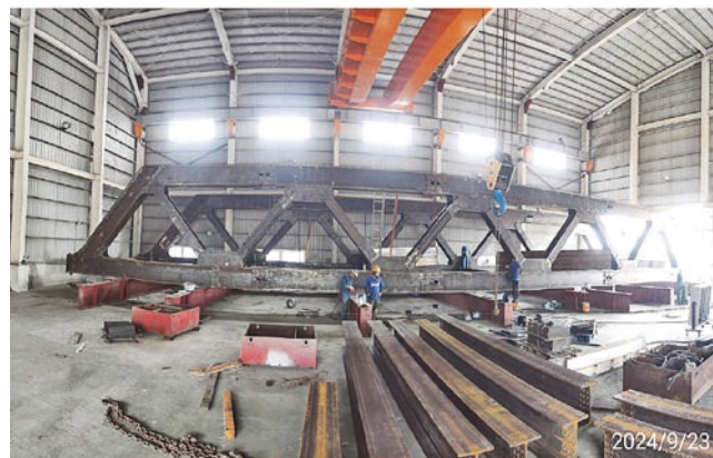
圖 3 小清水溪橋鋼構件於鋼構廠進行假組立照片
