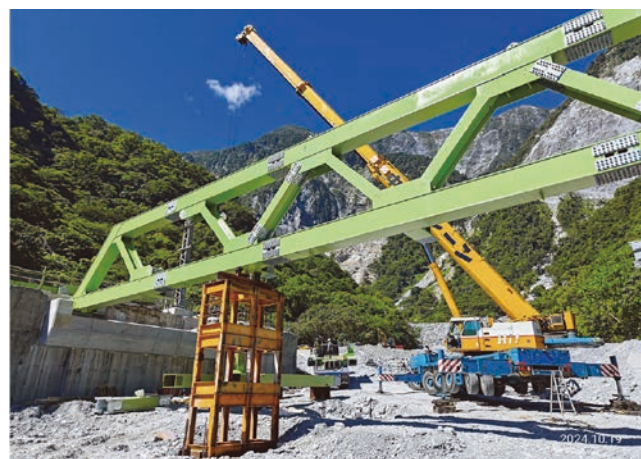
圖 4 西小清水溪橋鋼構件現場吊掛施工照片
