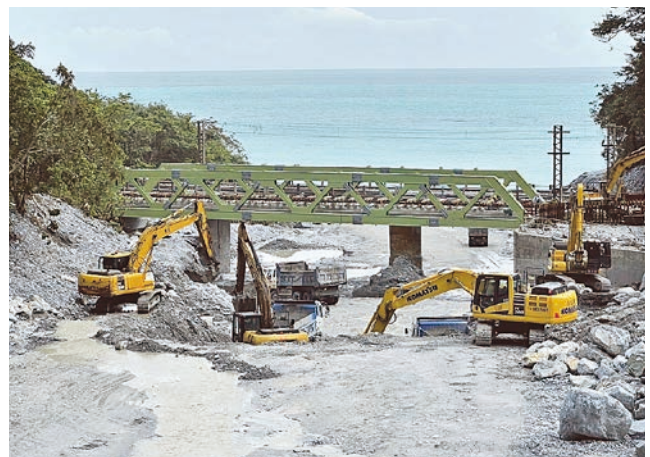
圖 5 小清水溪橋工程河道同步清淤之現場照片
