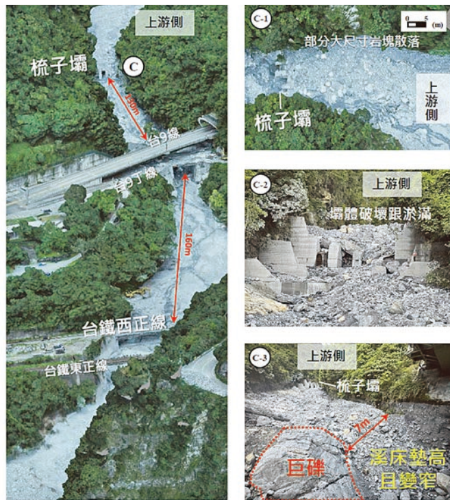
圖 6 上游溪床與梳子壩受災情形（圖 5 點 1）（資料來源：GeoPORT）
