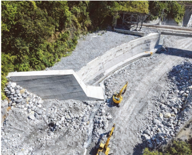
圖 15 新設導流翼牆與混凝土護岸 (20251211) [1]
