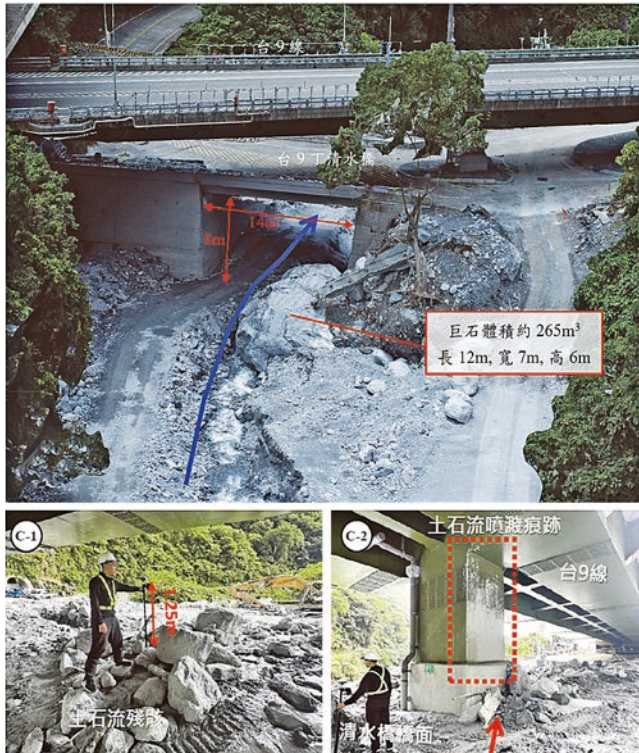
圖 7 台 9 丁線 (清水橋) 受災情形 (圖 5 點 2) (資料來源: GeoPORT)
