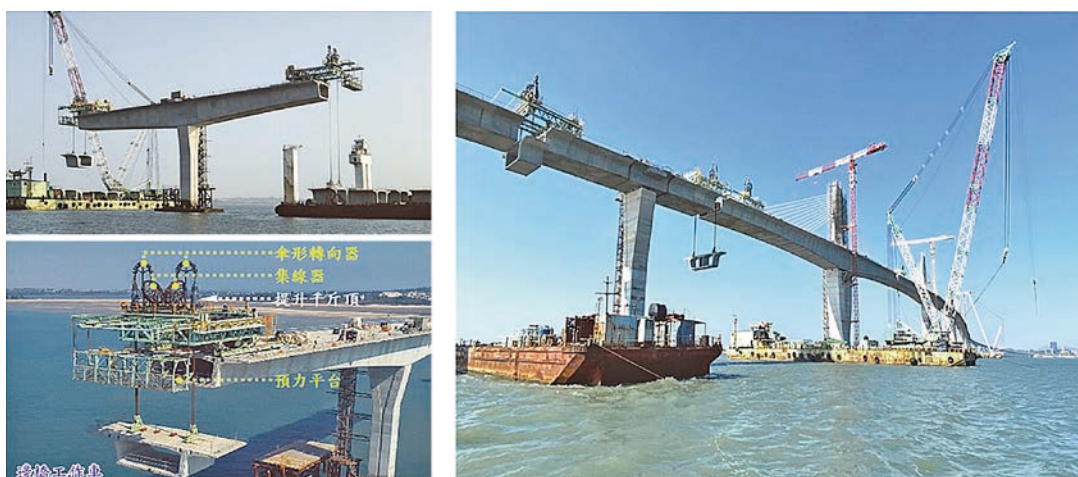
圖 18 海上預鑄節塊吊裝
