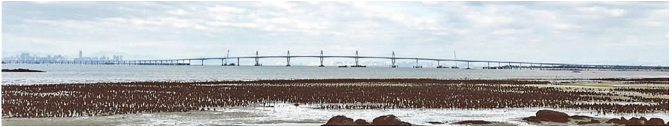
圖 9 橋梁跨徑漸進優美變化
