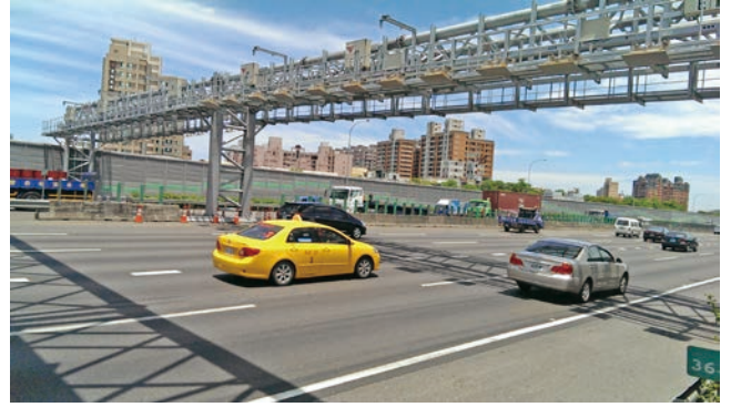
圖 7 臺灣 ETC MLFF 多車道自由流雙向共構門架
