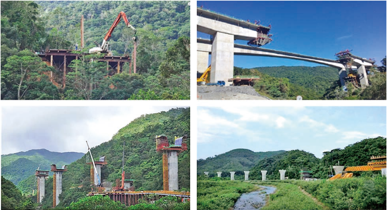
圖 7 橋梁自動化施工
