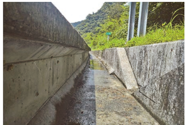
圖 24 邊溝生物逃生通道及反折防止入侵
