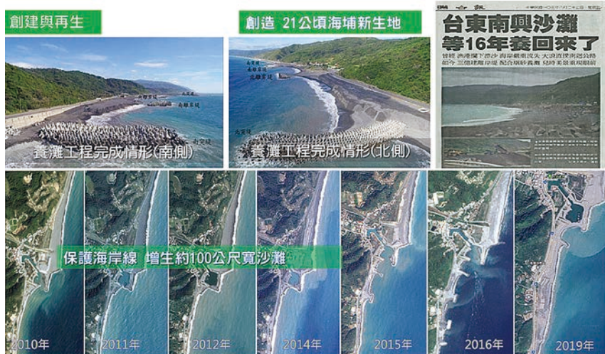
圖 10 台灣東部海岸線養灘工程
