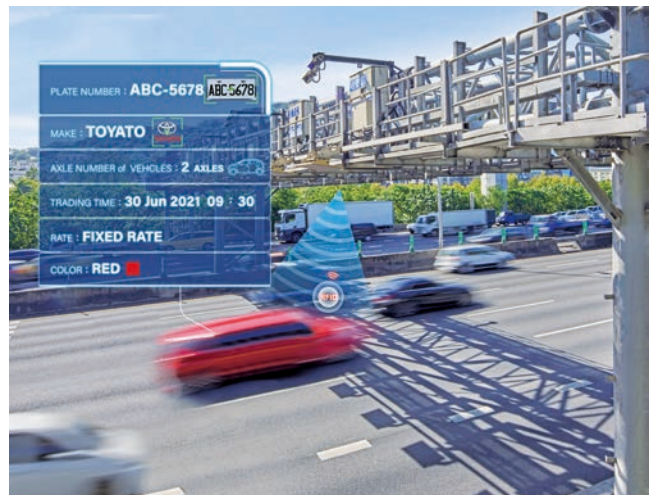
圖 8 車輛行經 ETC 門架互動示意
