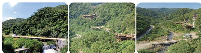
圖 12 施工臨時便橋與棧橋
