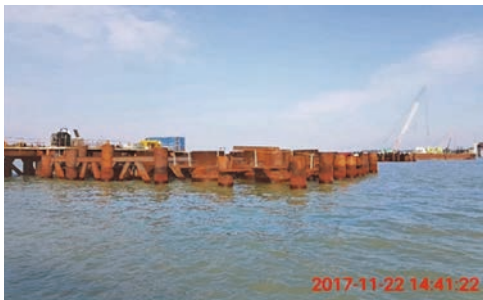
構台處漲潮狀況
