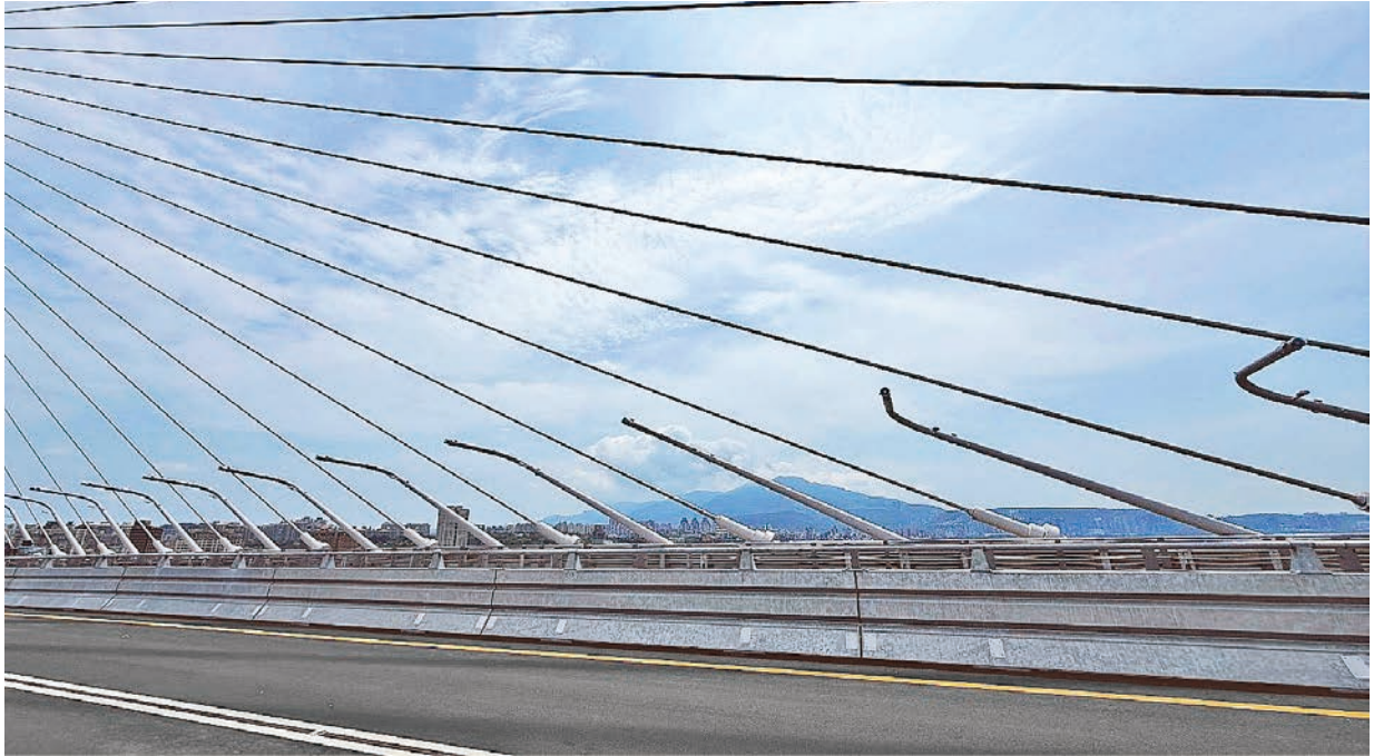
燈柱與傳統橋梁不同，不是直立，而是傾斜且與鋼索平行排列。
