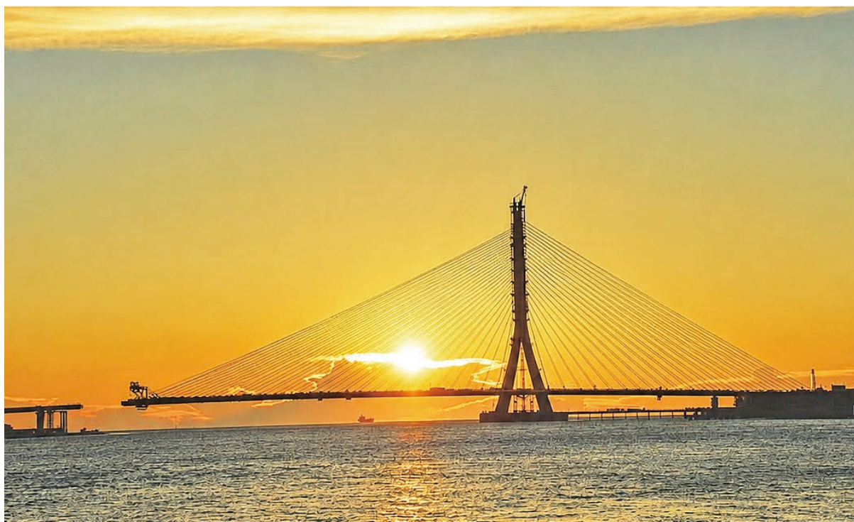
淡江大橋採用單塔不對稱斜張橋，橋塔不致於遮蔽或干擾夕陽。
