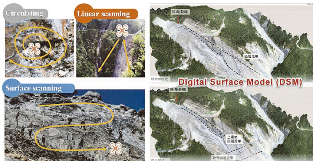
圖 10 UAV 應用於邊坡科技巡檢
