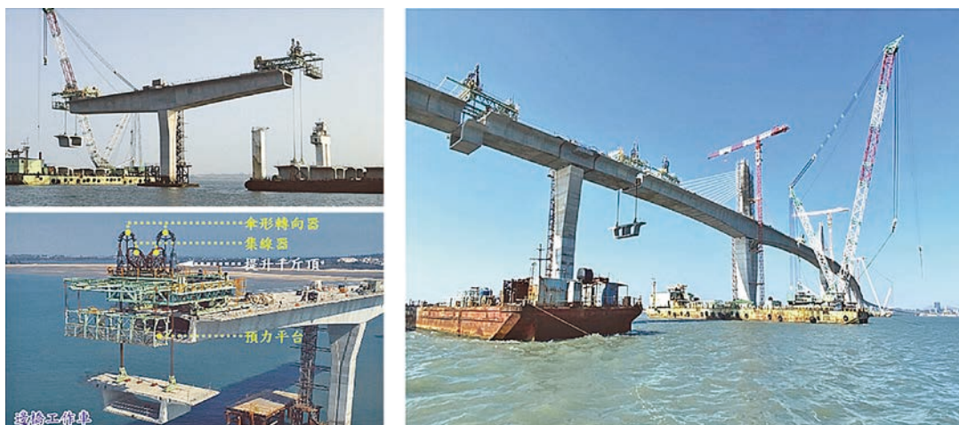
圖 18 海上預鑄節塊吊裝
