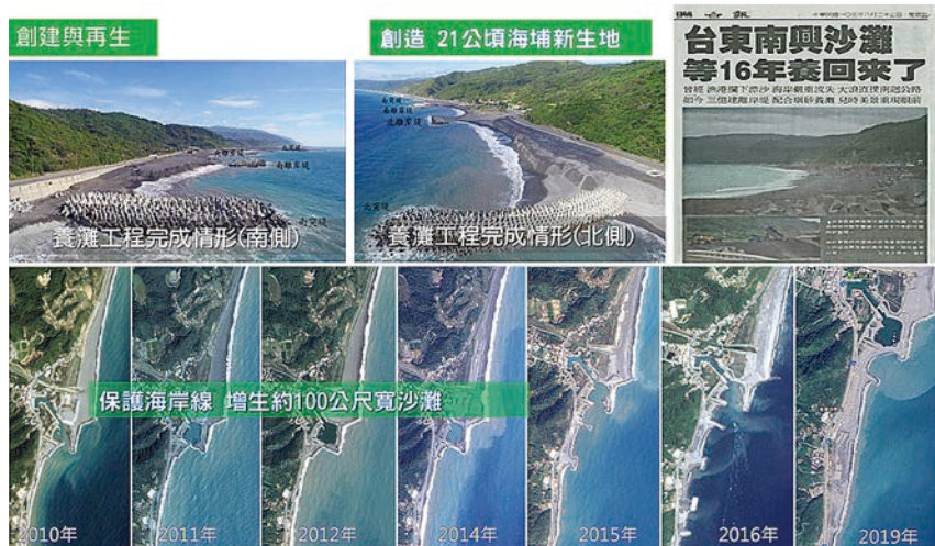
圖 10 台灣東部海岸線養灘工程
