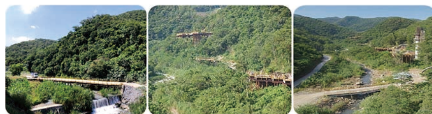
圖 12 施工臨時便橋與棧橋
