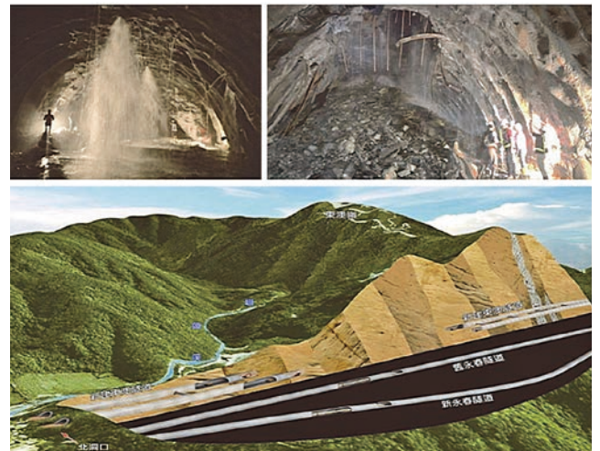
圖 11 新舊永春隧道施工照片與東澳隧道區位套繪
