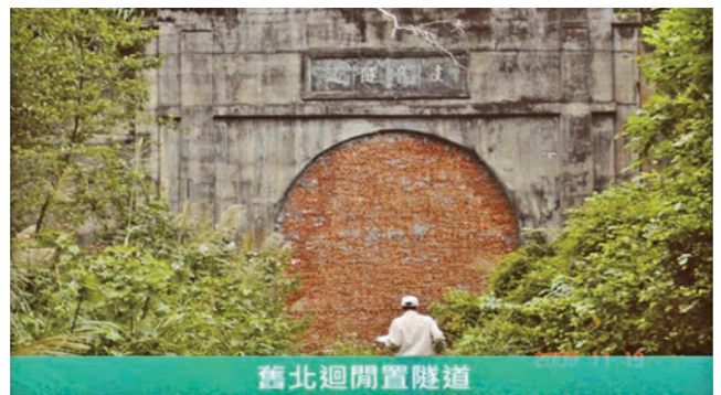
圖 8 施工利用舊北迴鐵路隧道
