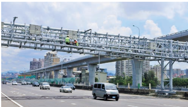
圖 4 遠通電收 EPC 工程師進行門架設備養護
