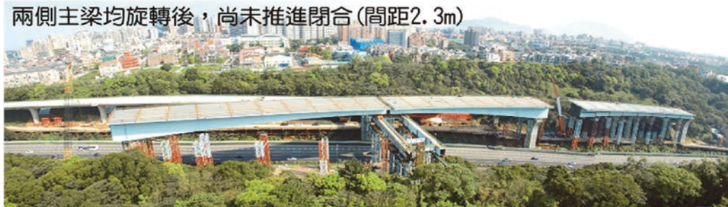
圖 7 林口段跨越橋配置及旋轉工法施作
