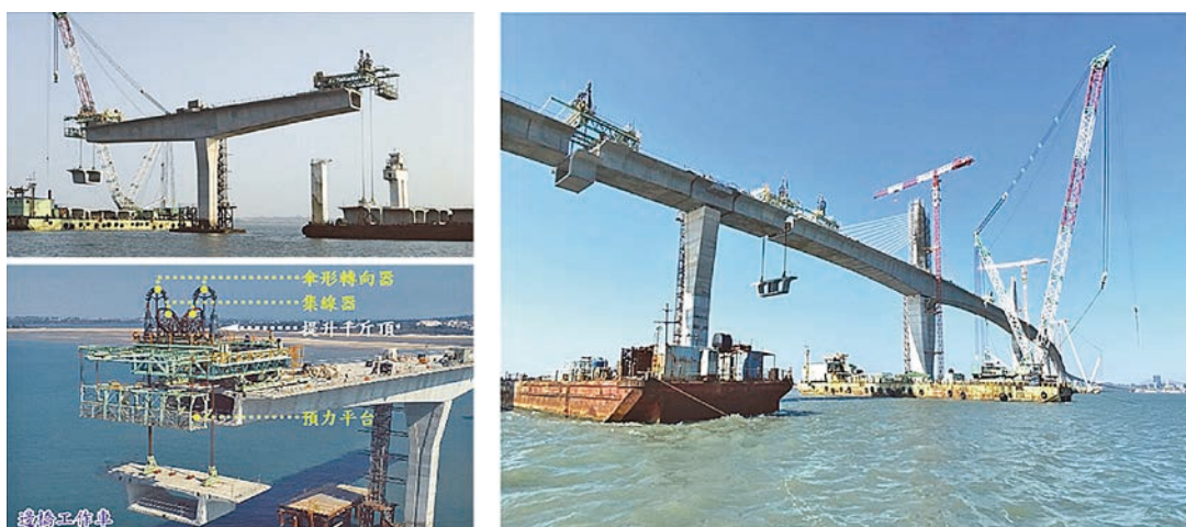
圖 18 海上預鑄節塊吊裝
