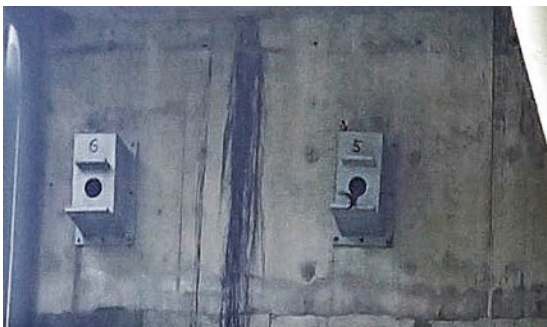
圖 5 高架橋下方鳥槽箱
