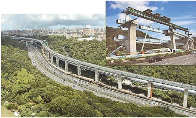
圖 5 林口段雙層橋配置及上構鋼梁吊裝
