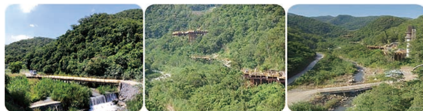
圖 12 施工臨時便橋與棧橋
