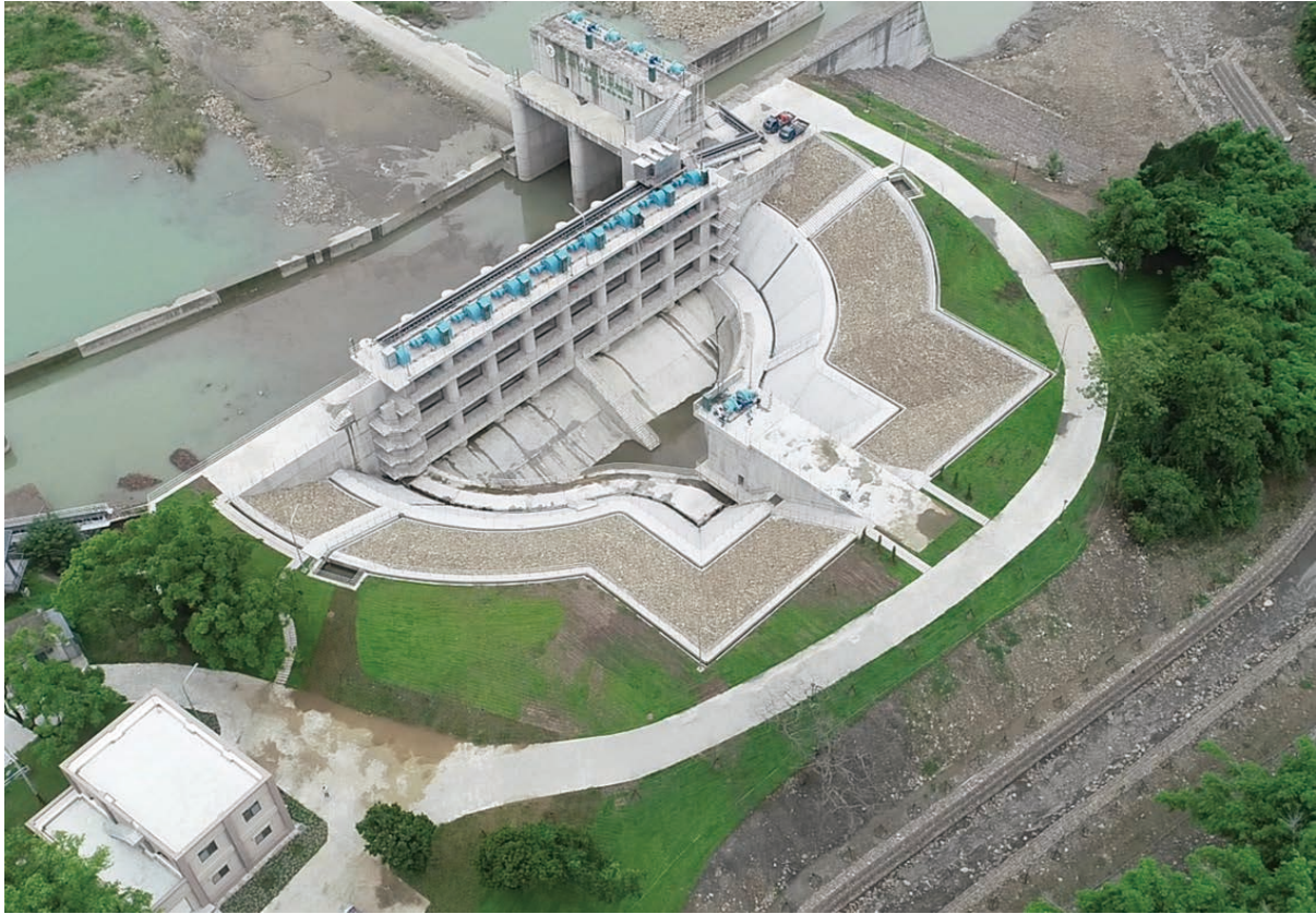
新烏山嶺引水隧道取水口
