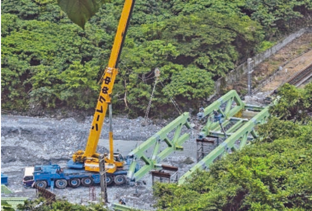
圖 16 河道區域範圍內鋼構橋梁組裝照片
