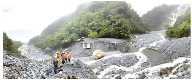
圖 2 凱米颱風後於臺九線之土石崩塌照片
