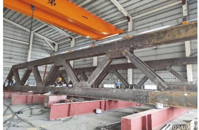
圖 17 進行鋼構廠內假組裝之照片
