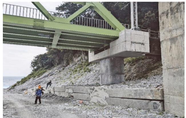
圖 18 將敲除之 PCI 梁作為橋墩保護工照片
