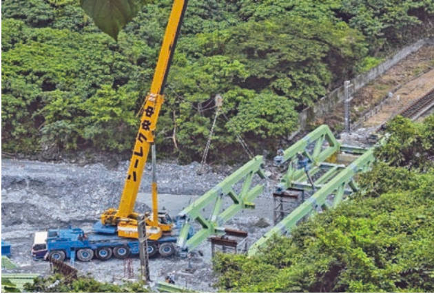
圖 16 河道區域範圍內鋼構橋梁組裝照片
