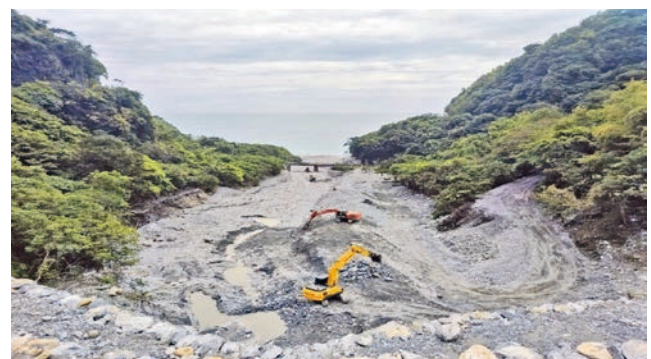
圖 15 災後施工便道之拓建照片
