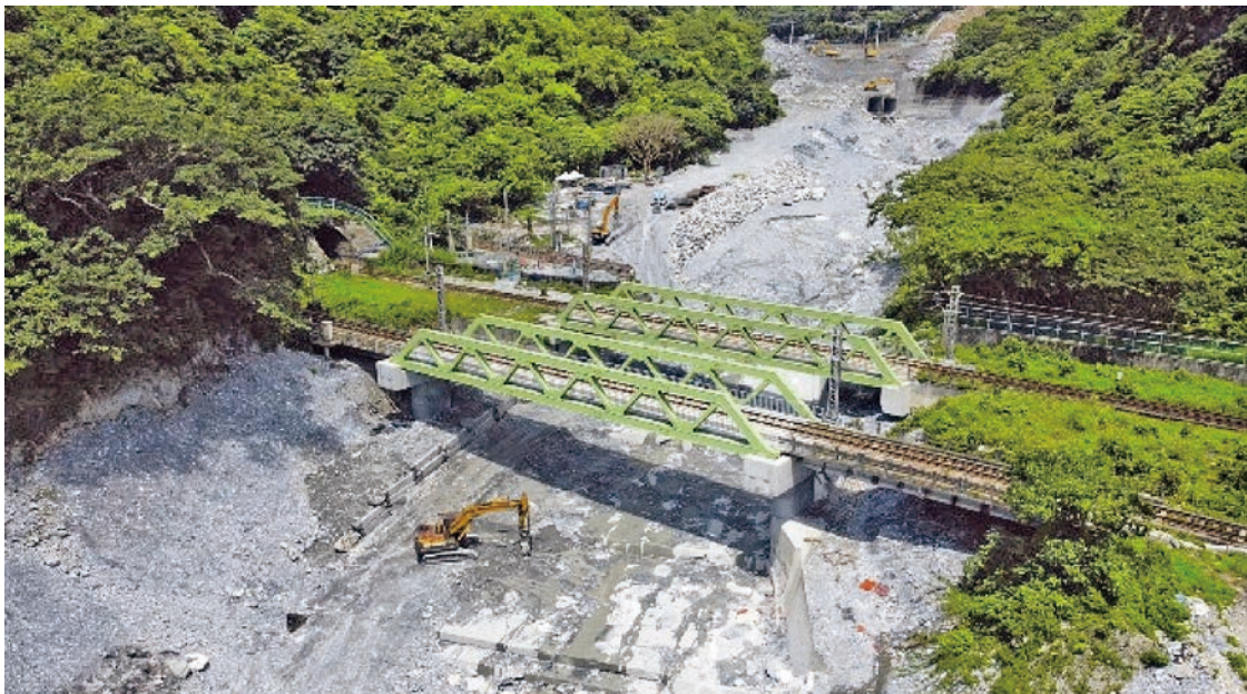
圖 5 小清水溪橋雙線改建完成照片
