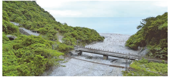
圖 3 凱米颱風後西小清水溪橋沖毀照片
