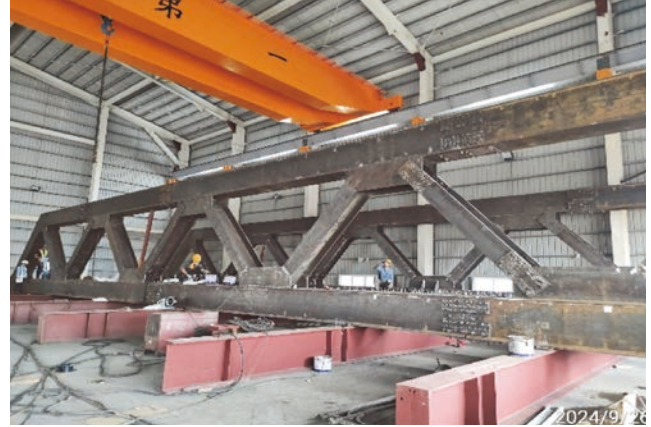
圖 17 進行鋼構廠內假組裝之照片
