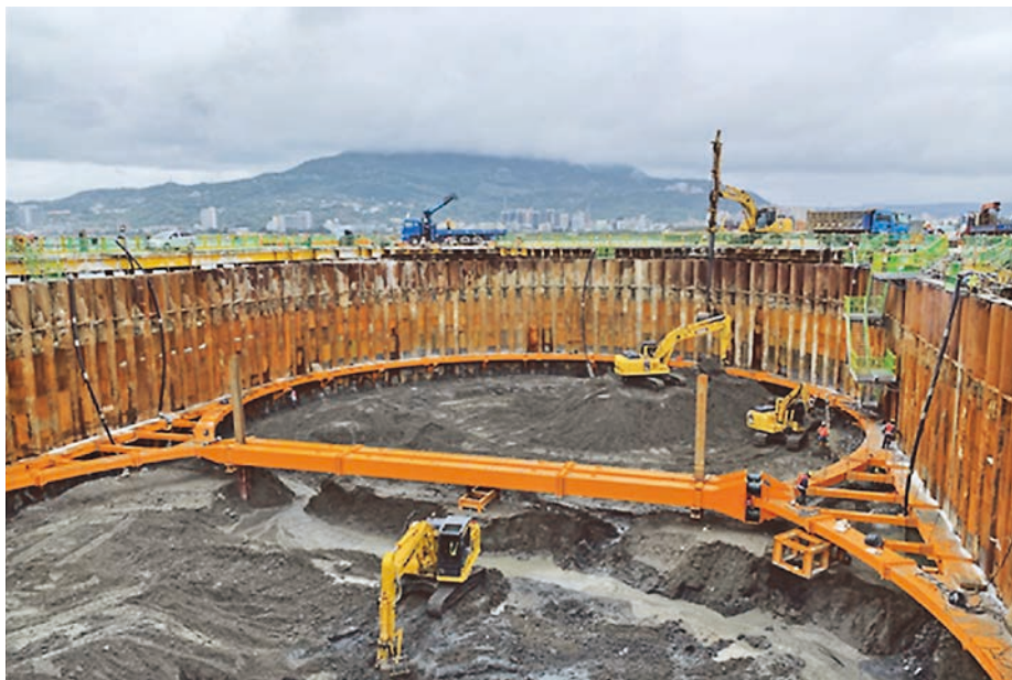
圖 8 2 層環型鋼箱梁現場施作情形
