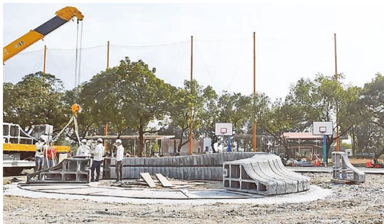
圖 8 3D 水泥列印快速乾式組裝
