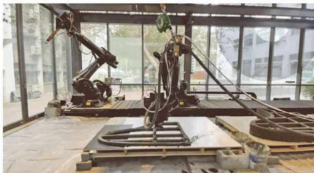
圖 7 機器人執行 3D 水泥列印
