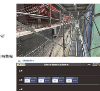
圖 12 施工架監測預警系統－無線壁連桿
