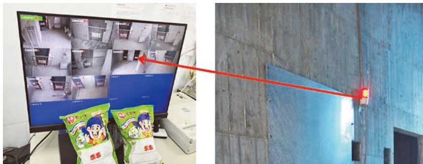
圖 7 CCTV 結合警示燈應用於電梯吊料警示
