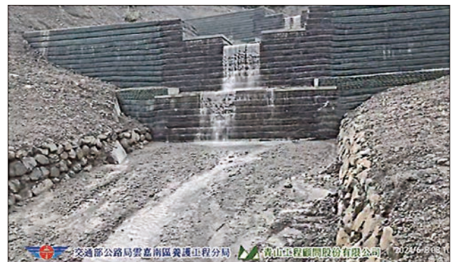
圖 10 阿里山台 18 線附近下游加勁潛壩 (Check Dam) 可能是全世界的首例
