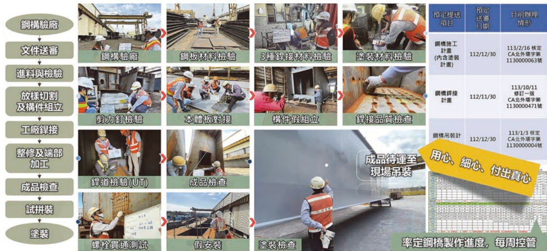
圖 4 上部結構施工（以鋼橋為例）
