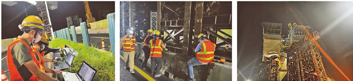
圖 6 鋼箱梁吊裝現地監測作業
