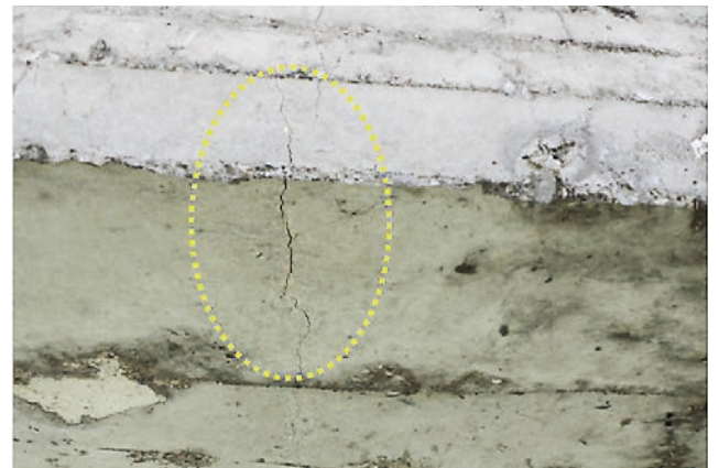
圖 8 石灼高架橋 PE4-PE5 箱型梁撓曲裂縫之目視檢測
