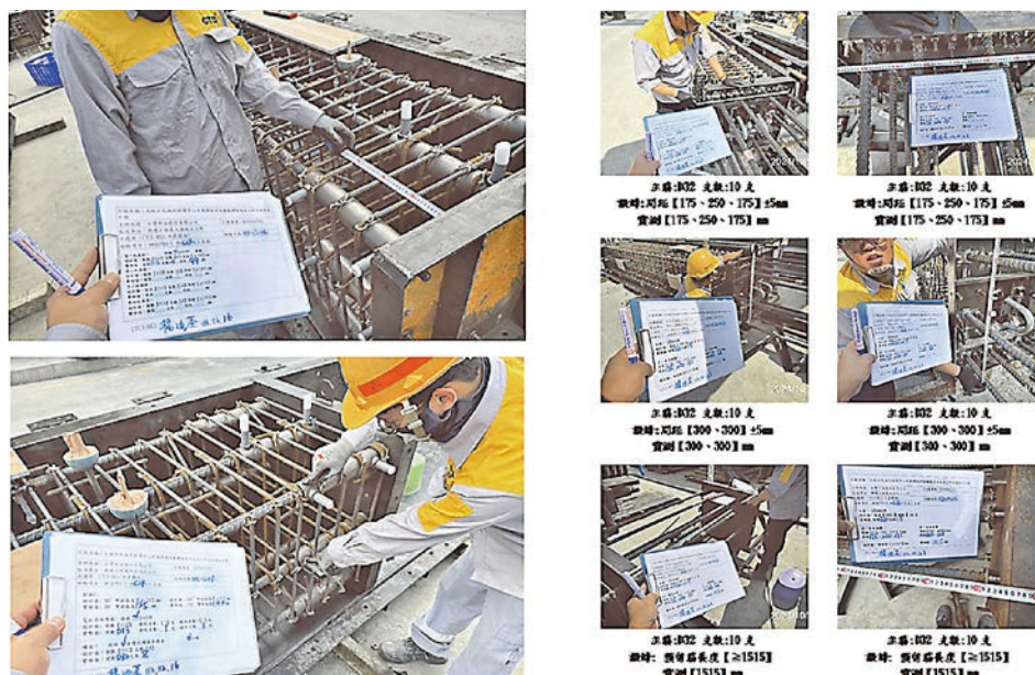
圖 2 柱構件之鋼筋自檢照片
