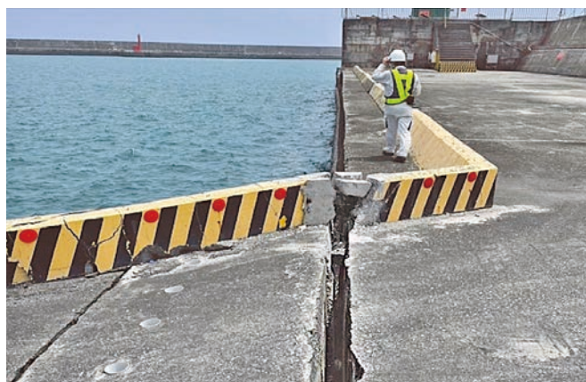
(b) 開裂約 0.2 m (點位 L7)
