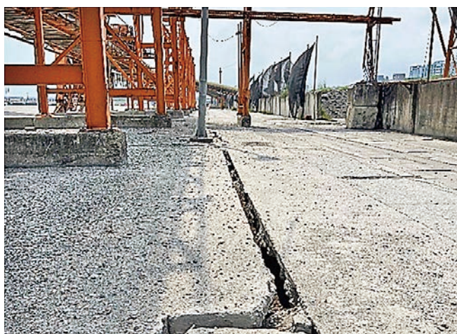
(a) 輸送帶旁鋪面下陷約 0.2 m (點位 L2)
