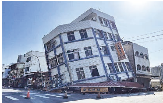
(a) 建築物地震發生後傾倒情形 [6]
