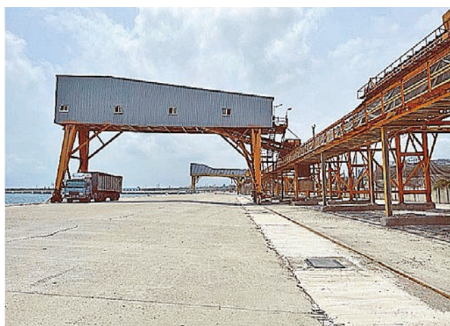
(a) 裝船機略有傾斜 (點位 L1)
