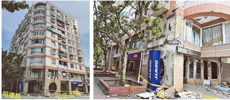
(a) 0403 主震發生後之破壞情形
