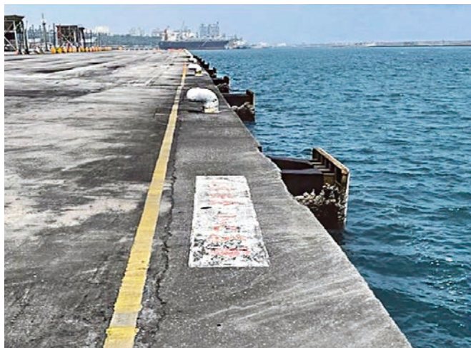
(a) 法線目視局部偏移 (點位 L8)
