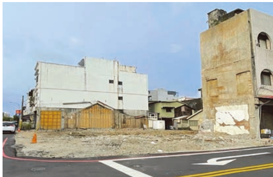
(b) 20140414 已拆除完成情形
