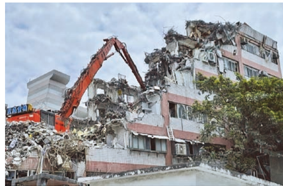
(e) 0423 餘震作用倒塌後拆除情形
