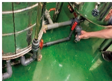
(a) 已修復之 RO 儲水桶連接管線
