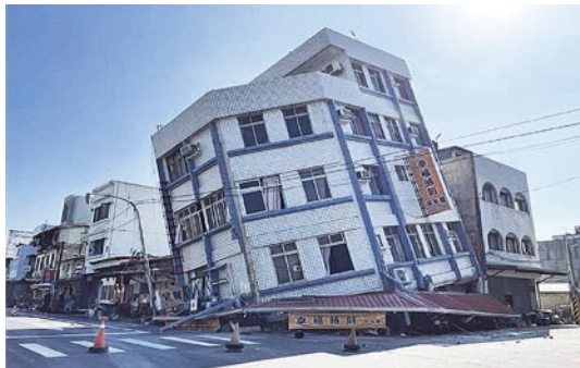
(a) 建築物地震發生後傾倒情形 [6]
