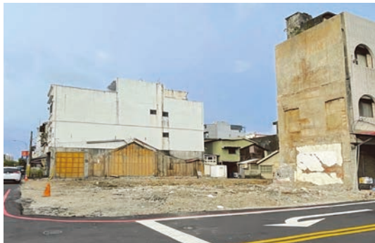
(b) 20140414 已拆除完成情形
