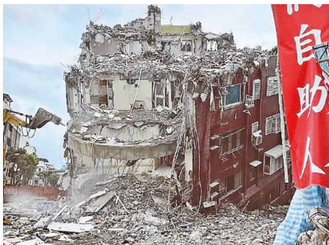
(b) 建築物傾倒後正面拆除情形
