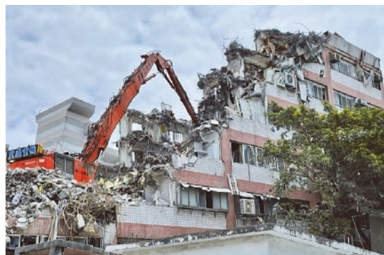
(e) 0423 餘震作用倒塌後拆除情形
