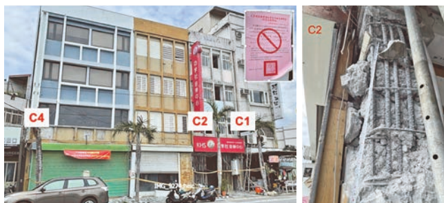
(a) 建築物地震發生後正面受損情形及 C2 之近照
