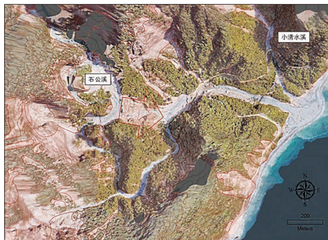
圖 10 匯德隧道東西無人機空拍 (2024/08/01；空拍照片安誼工程顧問詹家賓技師提供)
