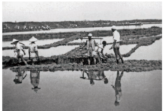
圖 1 截彎取直河道在積水的農田中開挖（黃世傑提供）
