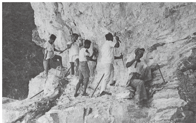
圖 1 榮工弟兄在岩壁上以手工鑽鑿 [1]
