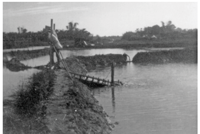
圖 2 兵工用自製的腳踏水車分區抽水排出（黃世傑提供）
