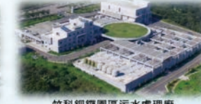
竹科銅鑼園區污水處理廠
