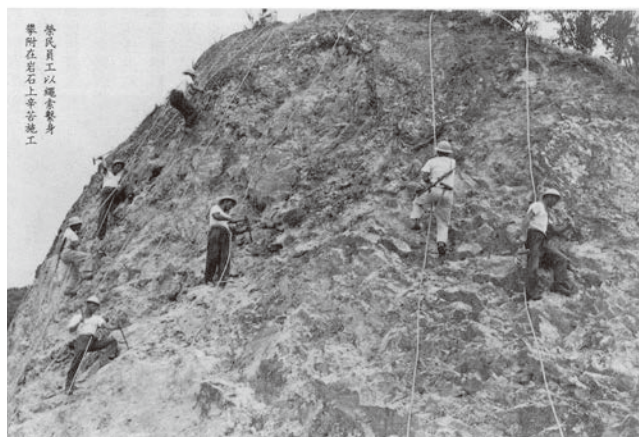
圖 2 榮工弟兄在岩壁上以繩索垂降施工 [1]
