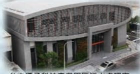
台中潭子科技產業園區污水處理廠
