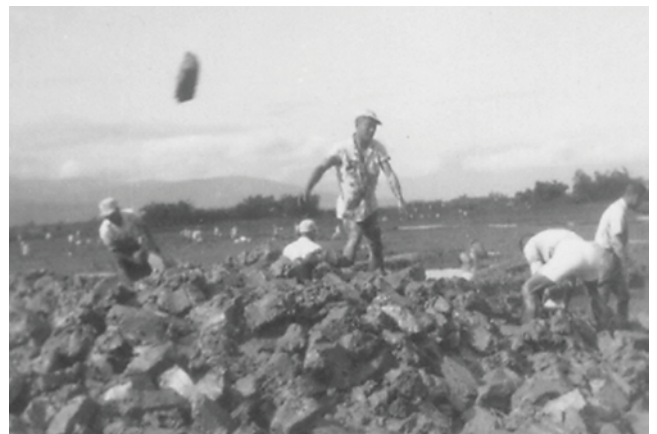
圖 3 黏土切塊以人力傳遞方式堆成土堤（黃世傑提供）
