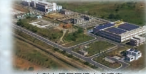
中科七星園區污水處理廠
