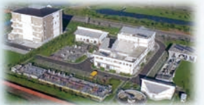
竹科城南基地污水處理廠
