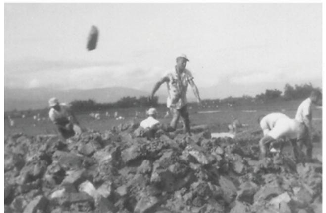
圖 3 黏土切塊以人力傳遞方式堆成土堤（黃世傑提供）
