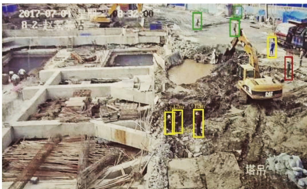
圖 11 用人工智慧 AI 來辨識工地施工人員不安全動作，並即時採取有效的管理措施
