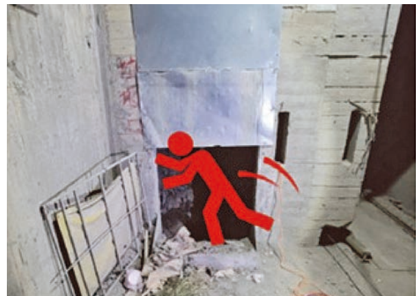
圖 1 垃圾管道間作業自開口墜落 [4]
