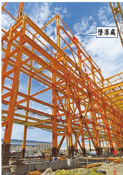
圖 3 安全母索及中間桿柱一併扯落並墜落至地面 [5]
