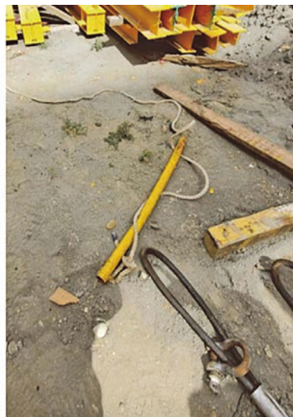
圖 3 安全母索及中間桿柱一併扯落並墜落至地面 [5]
