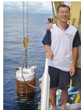
圖 2 各式常見之錨碇總類 [2] ，作者於巴西外海安裝吸力錨
