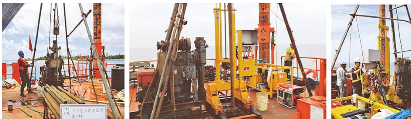
圖 7 鑽探平台搭載之油壓鑽機與 CPT 設備
