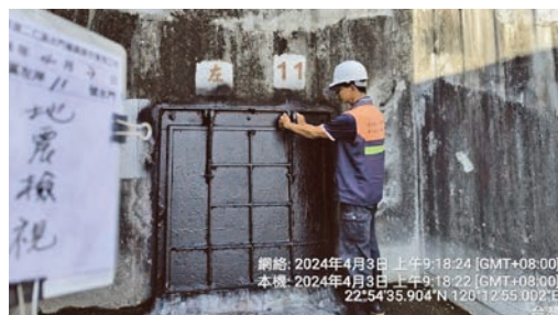
1130403 二仁溪水門檢查
