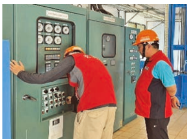
1130403 牡丹水庫閘閘室設備檢查
