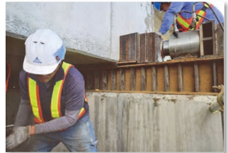
新秀姑巒溪橋緊急搶修頂升、橫移油壓千斤頂佈設
