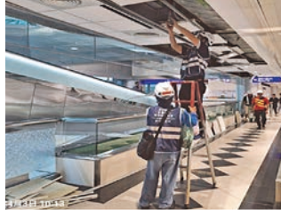
第二航廈二樓夾層受損天花板拆除
