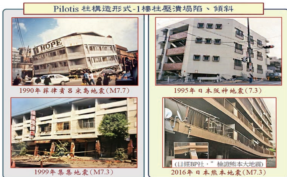
圖 9 建築物震害樣態－1樓柱壓潰塌陷、傾斜 [24]
