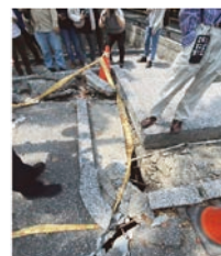
(c) 地面石墩受懸臂版撞擊導致開裂
