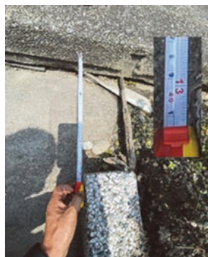
(d) 04/13 會勘時短向推擠距離約 400 mm
