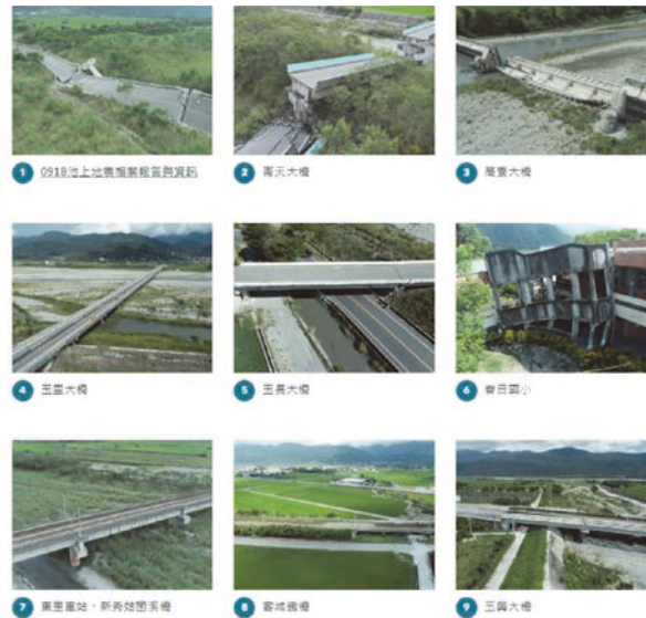
圖 9 受損橋梁建物故事地圖（0918 池上地震）
