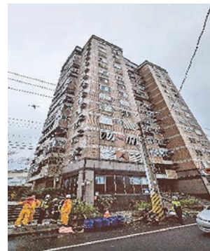
山海觀大樓震後東北側外觀
