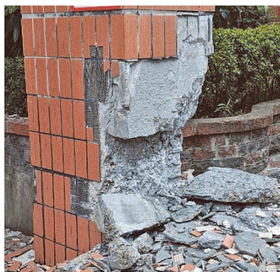
圖 39 鏡邑京華柱損壞（保護層過厚之虞）
