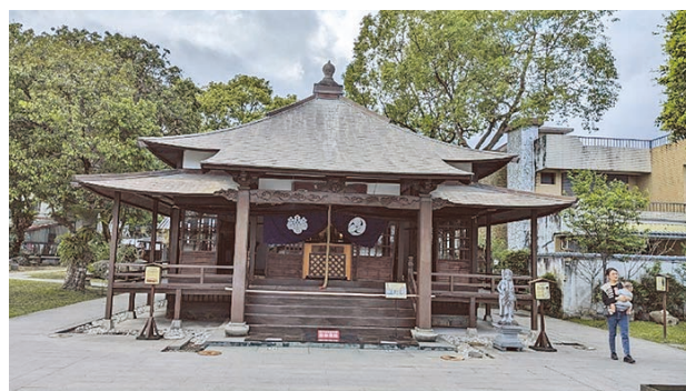
慶修院震後東南側外觀
