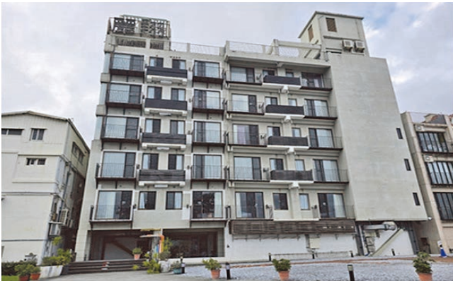
圖 15 鄰天王星大樓東南側已補強建物
