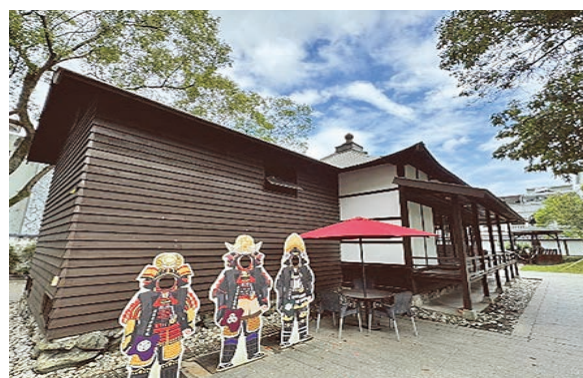
慶修院震後西側外觀
