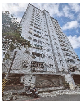
蓮花大樓震後東南側外觀
