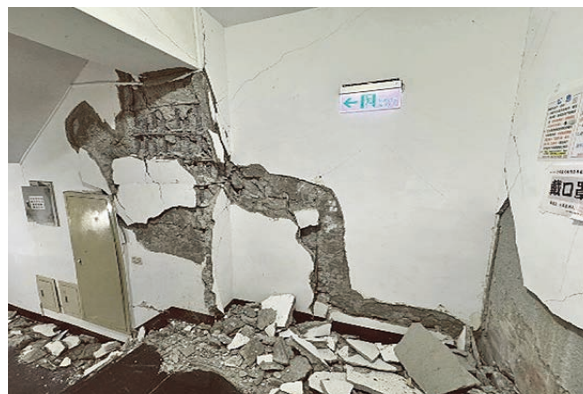
圖 41 鏡邑京華梯間柱體嚴重剝落
