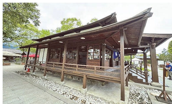
慶修院震後南側外觀
