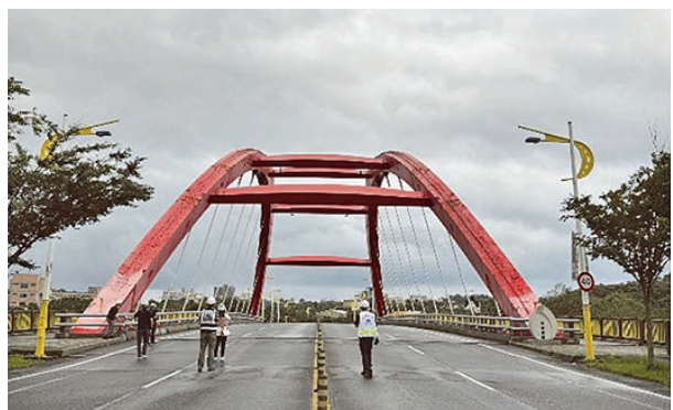
美崙溪橋震後西側外觀
