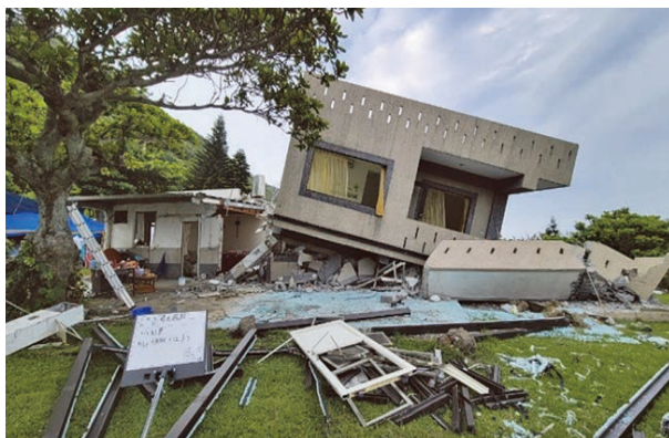
圖 95 0423 曙光假期崩塌外觀
