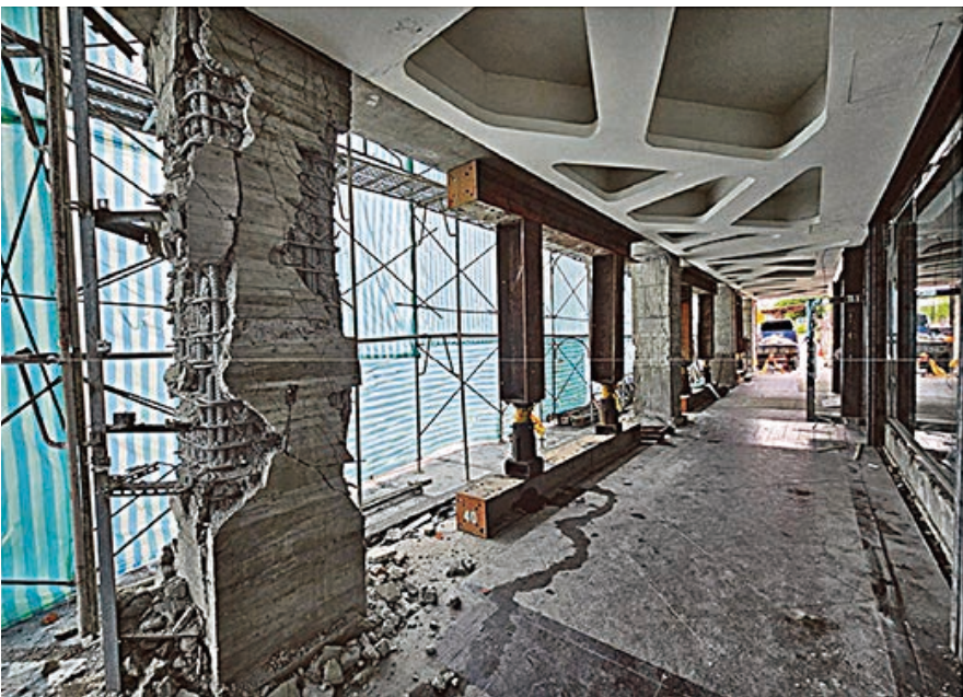
圖 84 0423 藍天麗池北側鋼構支撐
