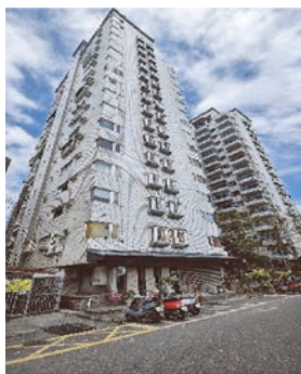
蓮花大樓震後西側外觀
