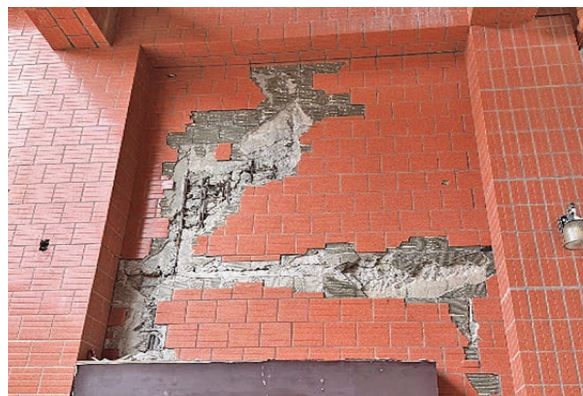
圖 44 鏡邑京華梯間牆 X 型 + 水平裂縫
