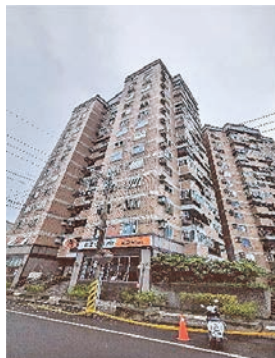
山海觀大樓震後西北側外觀
