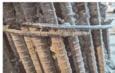
圖 66 鋼管紅茶店圓柱箍筋端部無彎鉤
