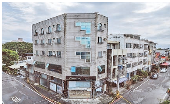
博愛街 52 號民宅震後西側外觀
