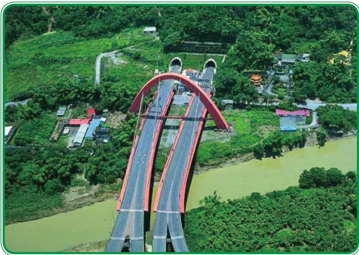
貓羅溪斜張橋（台灣世曦工程顧問股份有限公司提供）
