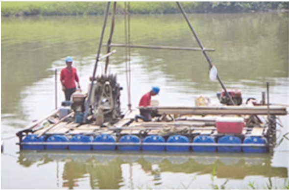
圖 2 鑽探浮台與小型鑽機
