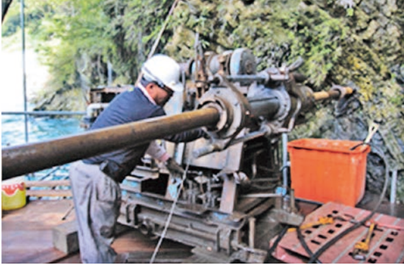
圖 1 鑽探搭架
