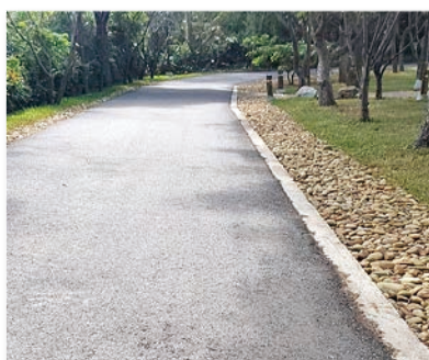
步道採用透水鋪面以增加蓄水空間
