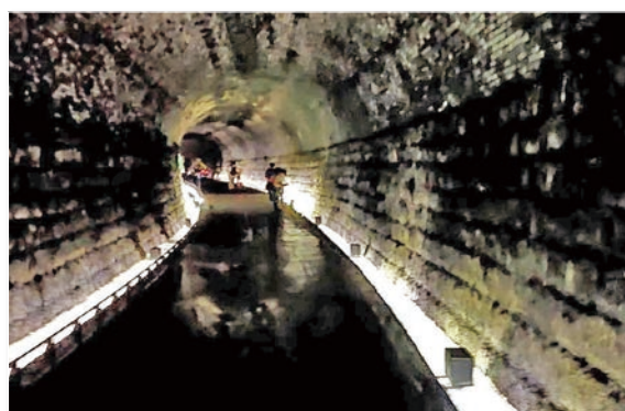
隧道內的鋼筋步道與地燈
