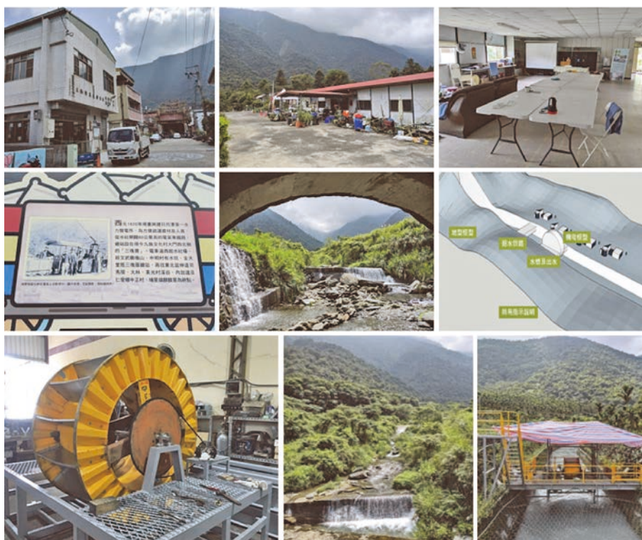
圖 4 東光社區向天圳小水力現場照片
