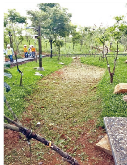
公園內遍佈草溝，以取代混凝土溝渠。
