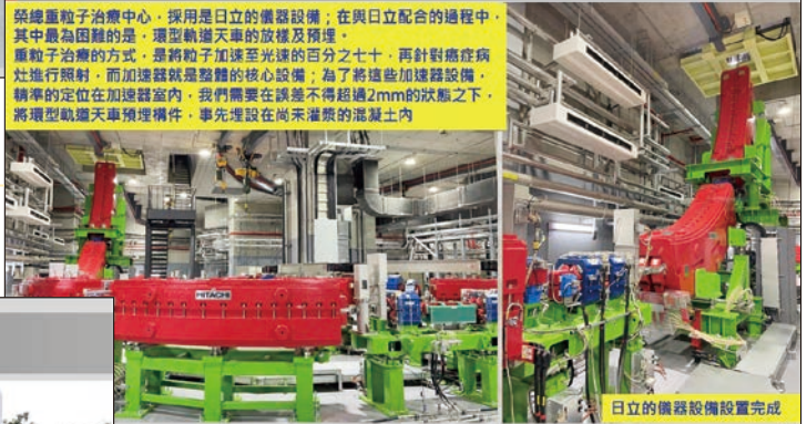
日立的儀器設備設置完成
