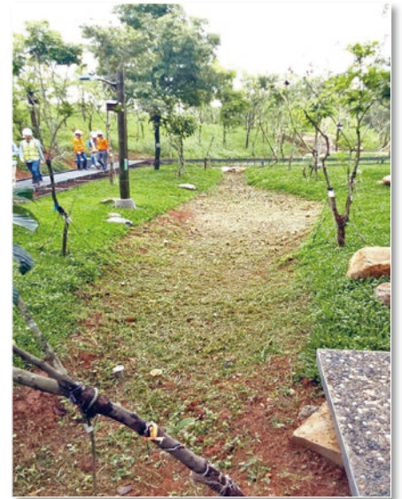
公園內遍佈草溝，以取代混凝土溝渠。
