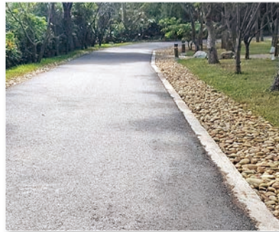
步道採用透水鋪面以增加蓄水空間
