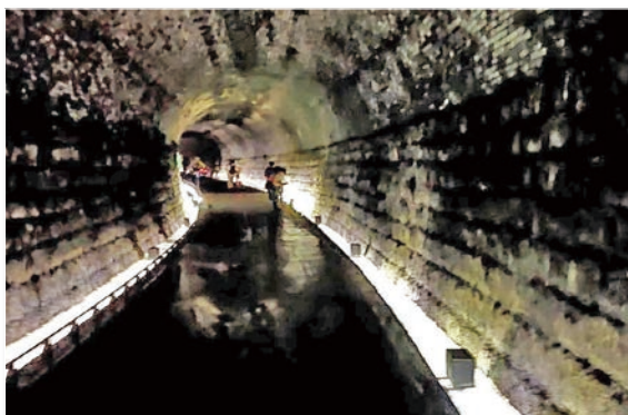
隧道內的鋼筋步道與地燈
