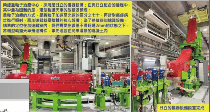
日立的儀器設備設置完成
